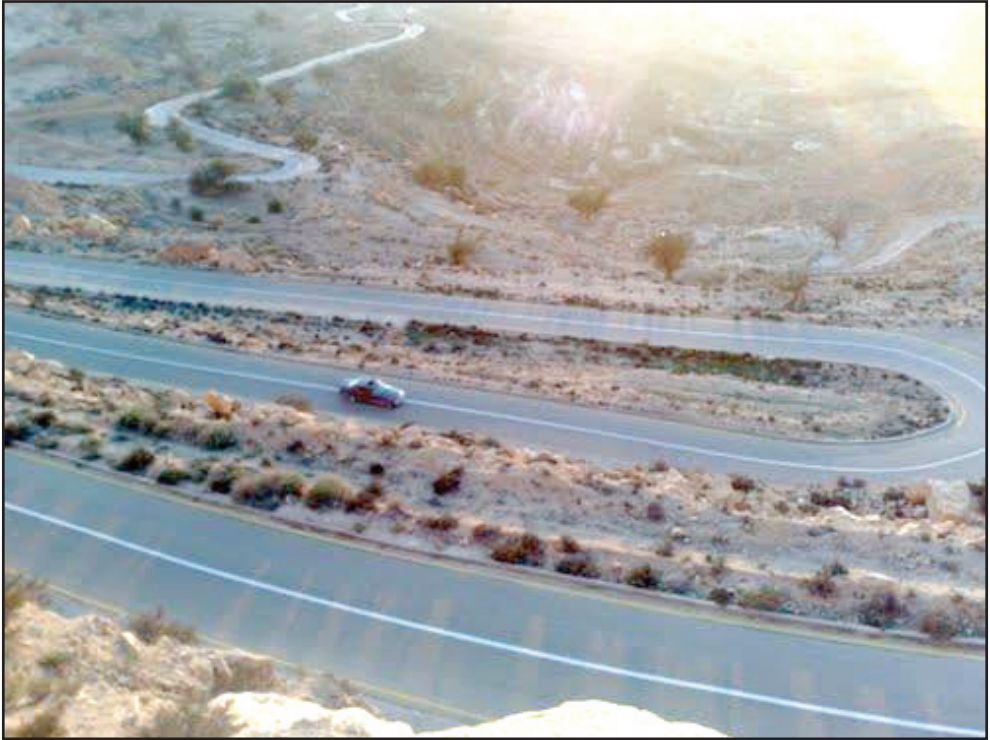
الصورة (3) صعوبة الطرق بالمنطقة
