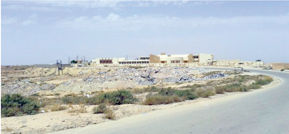
صورة (1) مخلفات البناء بجوار مبنى كلية الآداب.
